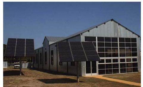
SE HAN INSTALADO PANELES SOLARES INDEPENDIENTES QUE SON VISIBLES PERO SE ENCUENTRAN EN LA PARTE TRASERA DE LA PROPIEDAD Y ADEMÁS SON COMPATIBLES CON EL CARÁCTER DEL EDIFICIO. (FUENTE: NPS)
