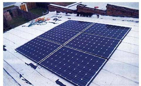
LOS PANELES SOLARES SE INSTALARON APROPIADAMENTE EN LA PARTE TRASERA DEL TECHO EN ESTA CASA HISTÓRICA Y NO SON VISIBLES DESDE LA ELEVACIÓN PRIMARIA. (FUENTE: NPS)
